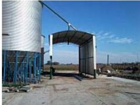
Instalación para descarga bajo techo y con paredes laterales para reducción de la emisión de polvo y material particulado (MP)
