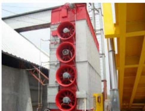
Foto 4. Bateria de ventiladores de una secadora de granos.
