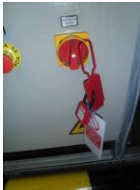
Dispositivo de bloqueo, con candado de Bloqueo y tarjeta identificativa correspondiente
