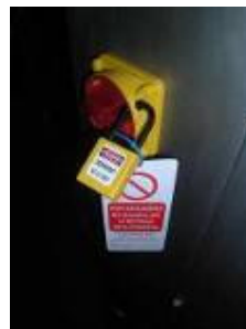
Candado de Bloqueo y tarjeta identificativa correspondiente
