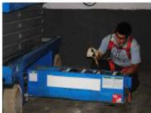
Figura 24. Falta de EPI en la comprobación o manipulación de las baterías
