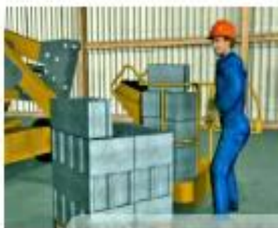
Figura 17. Plataforma de trabajo sobrecargada.
