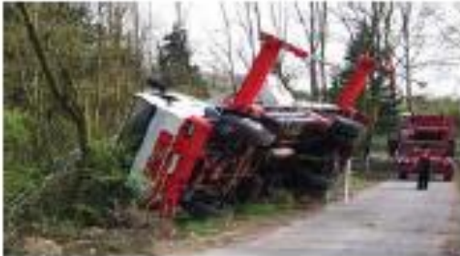
Figura 9. PEMP sobre camión volcado por efectuar trabajos sobre una superficie en mal estado o de poca resistencia
