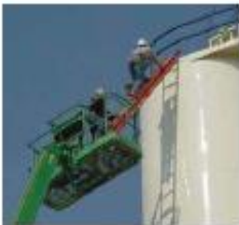
Figura 10. Acceso a una estructura utilizando medios auxiliares
