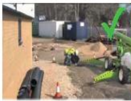
Figura 23. Evaluación previa de las condiciones de terreno.
