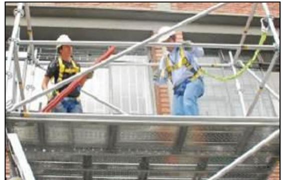
generales que deben cumplir los andamios utilizados en el rubro de la construcción y afines. Esta norma se aplica a todas aquellas estructuras provisionales, que suelen utilizarse para el soporte o sostenimiento de personas, materiales y herramientas, durante la ejecución de trabajos en altura.
