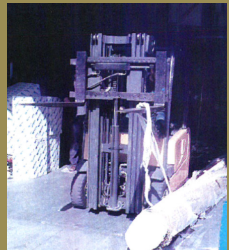
Operación de sacar el mazo de tubos del almacén agarrado por la horquilla arrastrando hasta el exterior
