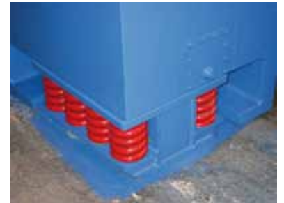
Figura 18. Soporte antivibraciones (Fuente: Arisa).
