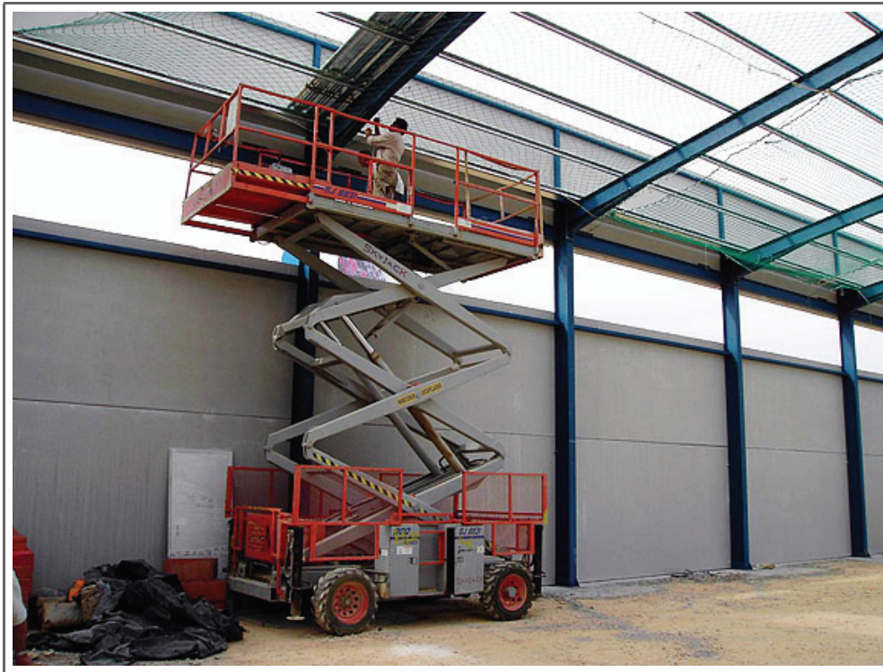
Montaje de la red de seguridad del sistema S desde una plataforma elevadora
