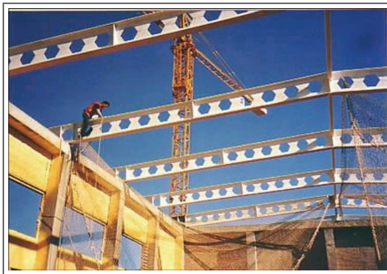
Montaje de la red de seguridad del sistema S sobre las propias vigas metálicas de la cubierta. Trabajador con sistema anticaídas sujeto mediante su componente de amarre rodeando la propia viga.
