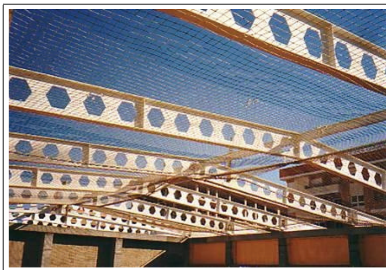
Red de seguridad Sistema S sujeta a las propias vigas metálicas de la cubierta
