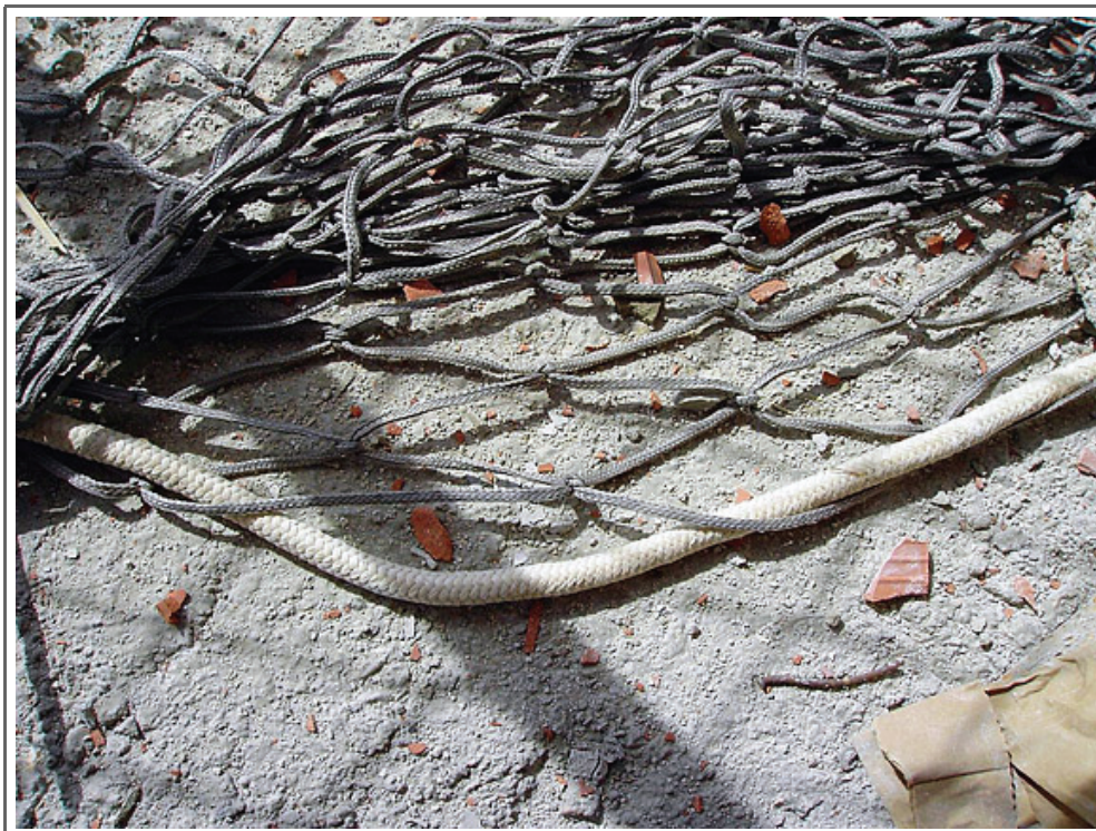
Red con cuerda perimetral únicamente pasada malla a malla
