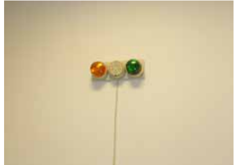
Indicador lumínico y sonoro de emisión de radiación, para la prohibición de ingreso.
