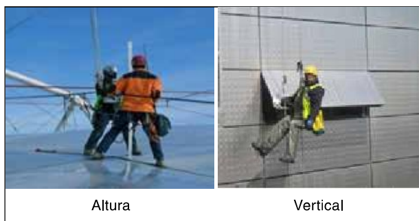
Figura 1. Ejemplo de trabajo en altura y vertical.
