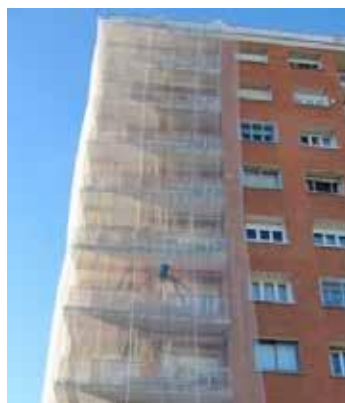
Figura 9. Instalación de una red de protección.
