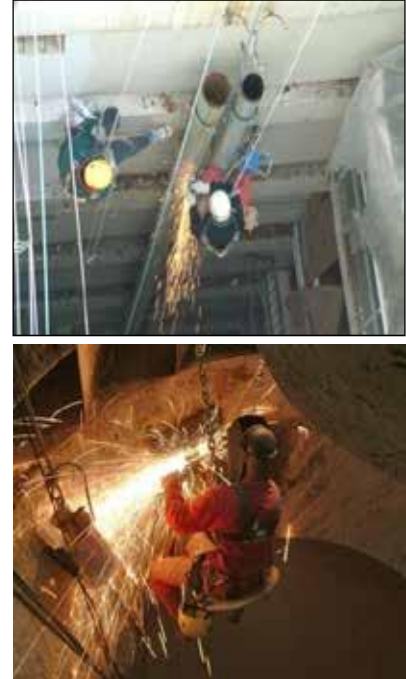
Figura 12. Trabajadores protegidos del riesgo de proyección de partículas.
