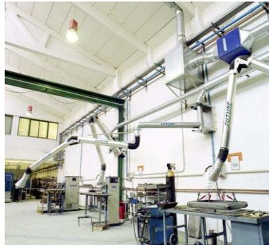
En industrias grandes en los que existan varios de puntos de trabajo se pueden instalar varios de estos **equipos en batería** unidos a **un conducto principal del que absorbe un extractor general**. Estas instalaciones **se deben calcular adecuadamente** ya que si la pérdida de presión en su red debido a los múltiples puntos de captación es muy elevada la extracción será inadecuada.
