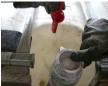
Ruptura del Registro de la Válvula
