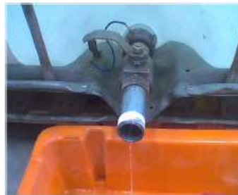
Fugas en el sistema de Bola (Cierre)
