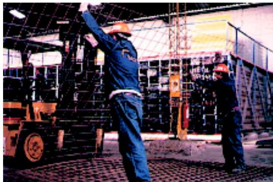
Si dispone de poco espacio para almacenar mallas y no cuenta con un dispositivo para apilarlas, puede colocar provisoriamente un número reducido de ellas adosadas a una estructura firme y amarradas individualmente en ambos extremos.
