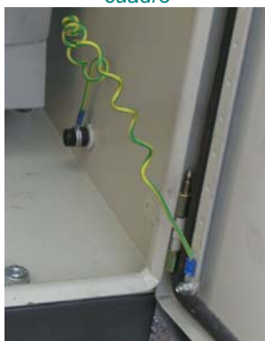
Detalle toma de tierra en cuadro
