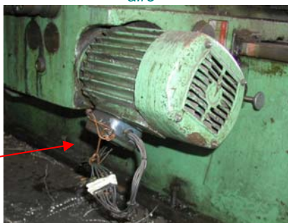
Empalme incorrecto y al aire
