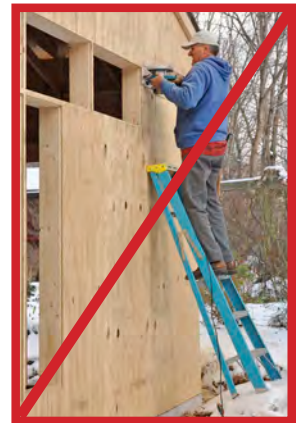
Escalera estándar usada en una configuración no aprobada
