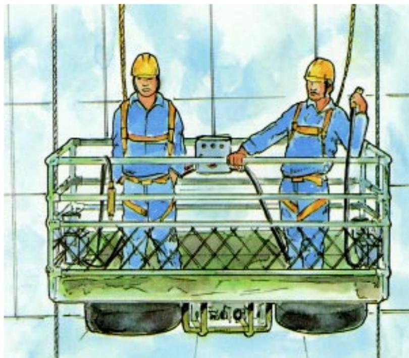
Una vez montado el equipo se debe probar la instalación, elevando el andamio hasta 30 cm. sobre el piso con una carga 4 veces mayor que la que ha de soportar en condiciones normales (aproximadamente 480 kg/m<sup>2</sup>).
