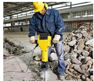
Específicamente existen cierto tipo de máquinas o herramientas que producen vibraciones riesgosas, dentro de las cuales se puede señalar aquellas de *alta frecuencia* cuyo rango es de 20 a 1000 Hz, dentro de las cuales se encuentran las herramientas manuales rotativas, eléctricas y neumáticas, así como herramientas percutoras como pulidoras, molinos, lijadoras, martillos picadores, motosierras, martillos neumáticos, taladros, remachadoras, entre otras.
