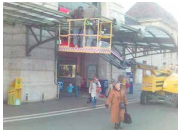
Figura 19. Personas circulando bajo la vertical de una PEMP sin balizar
