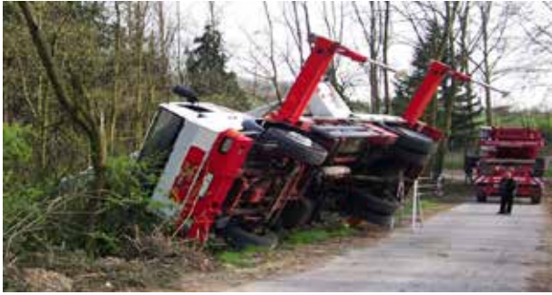
Figura 9. PEMP sobre camión volcado por efectuar trabajos sobre una superficie en mal estado o de poca resistencia
