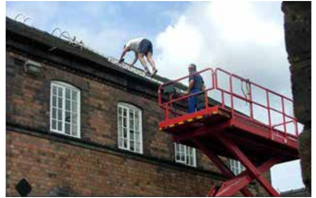
Figura 30. Uso indebido de la PEMP.
