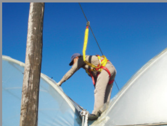
Adaptación del trabajo con arnés y línea de vida, en invernadero.
