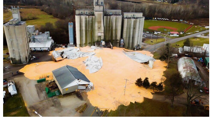
EEUU, Miami Valley, silo metálico (1975) colapsado enero 2018
