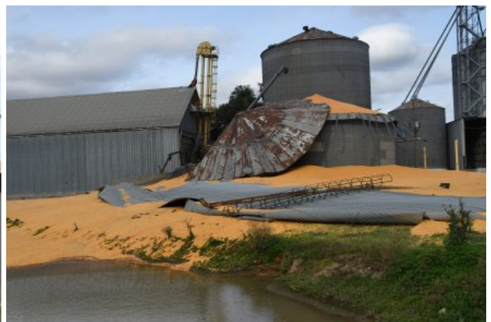
EEUU--DFP Ag silo de 1980 , oxidado, colapsa el 7.02.2022
