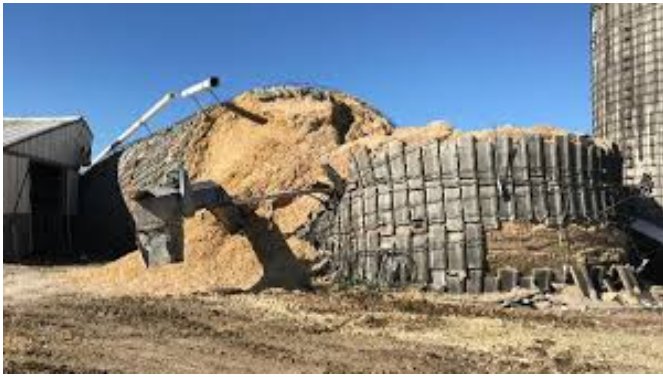
EEUU, silo de duelas de hormigon (1960) colapsado en 2017
