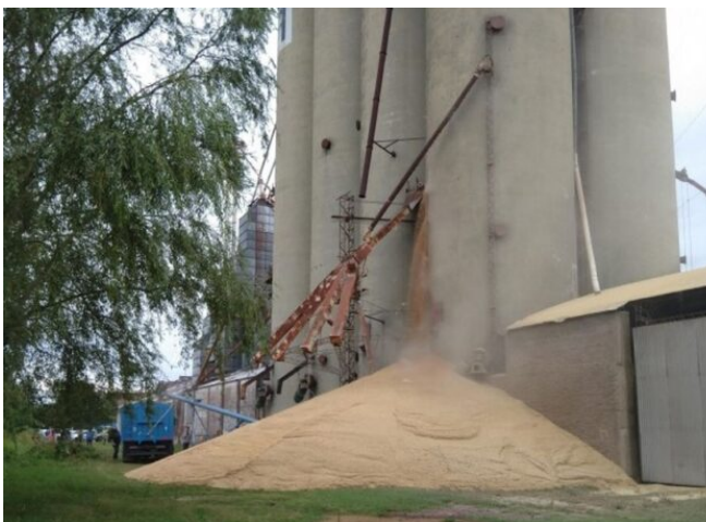
Argentina-Rojas (PBA) silo de 1966 agrietado el 30.01.2021
