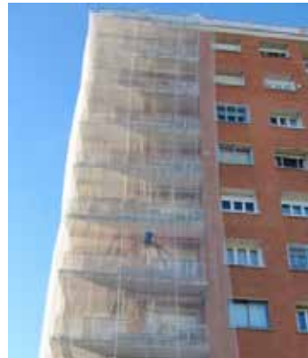
Figura 9. Instalación de una red de protección.
