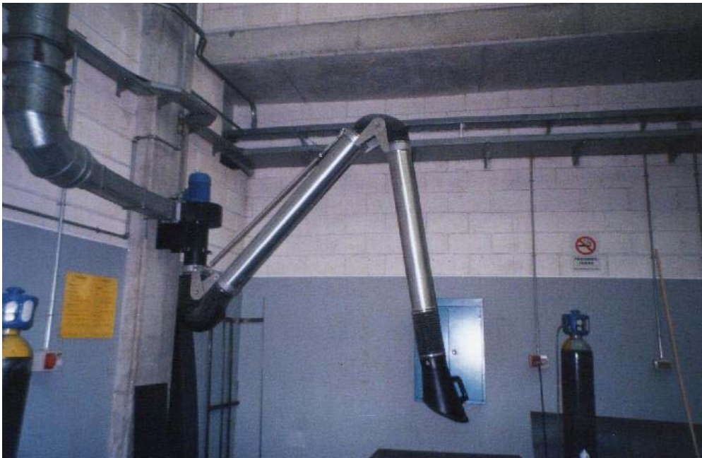
Figura 14. Boca móvil de aspiración de humos de soldadura
