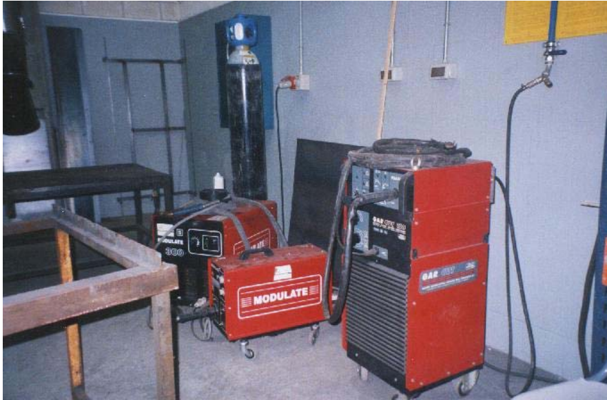
Figura 13. Grupos de soldadura eléctrica por arco tipo MIG
