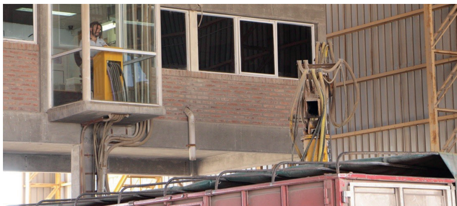
Vista de una caladora mecanizada operada desde una cabina en una playa de precalado.
