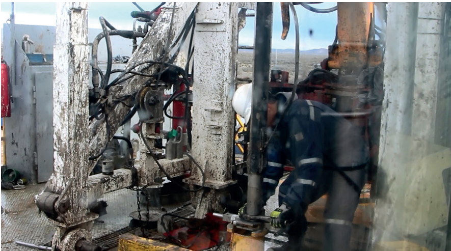
Maniobra de bajada y torque de caños en una boca de pozo, durante un perfilaje con fuente de neutrones.
