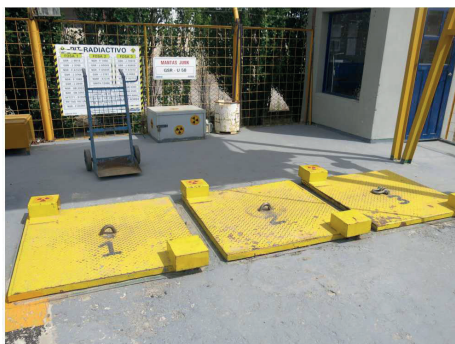
Dos tomas de un búnker de almacenamiento de fuentes y material radiactivo, donde pueden apreciarse el dosímetro de área y los fosos.
