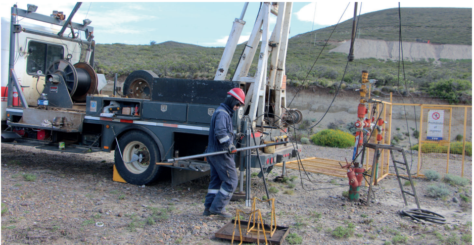
Desmontaje de herramientas de trazado, con los caballetes ya dispuestos para depositar el inyector.
