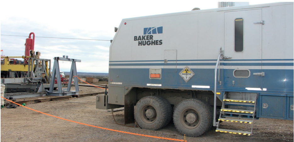
Demarcación de zona limitando la circulación. En esta maniobra se contempló el riesgo de rotura de cable asociado a riesgo radiológico en el tendido perimetral de cadenas.
