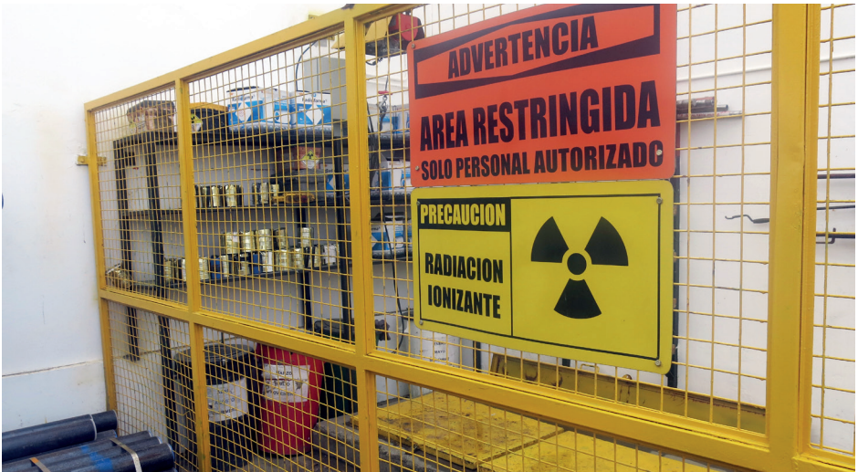
Bunker de base con cartelería restrictiva e identificatoria del riesgo radiológico, con zonas de almacenamiento para ^{131}\text{I} y fuentes selladas en fosos.
