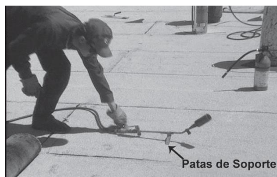
Figura 1. Siempre establezca el soplete de mano en su soporte.
