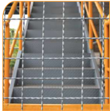
Mantener los accesos, las vías de tránsito, las vías de evacuación y las salidas de emergencia despejadas, desbloqueadas y señalizadas
