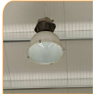
Se colocarán fuentes de luz frías ( T > 5000 \text{ }^\circ\text{K} ) cerradas y fáciles de limpiar
